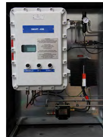
防护外壳内的 SMART 40M EXD 型设备
